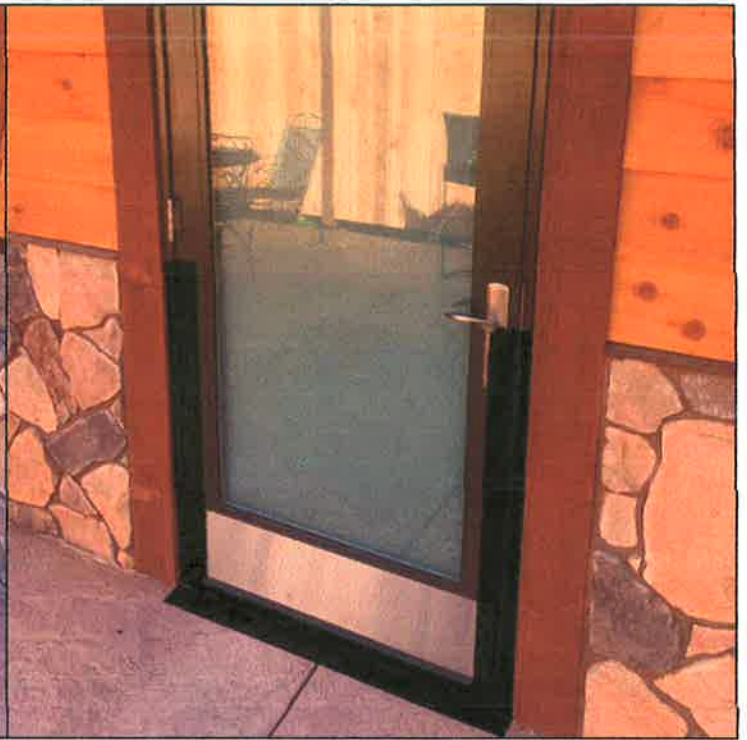
MENS RESTROOM DOOR
