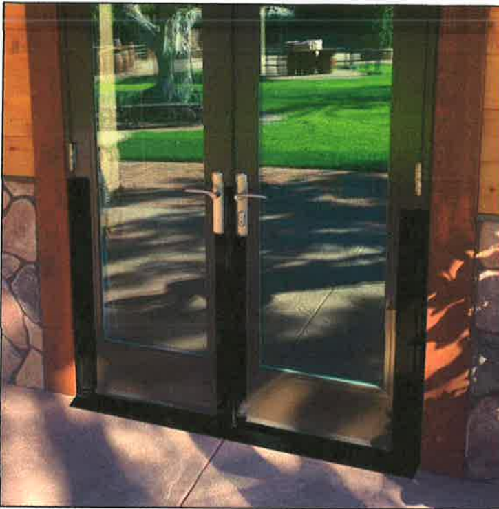
DRESSING ROOM DOUBLE DOOR
