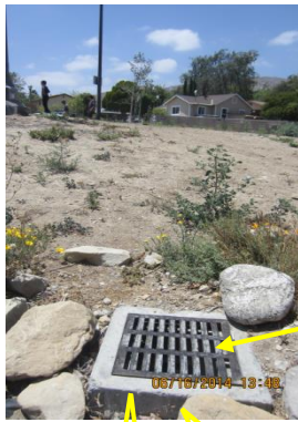
Sedimentation Manhole
