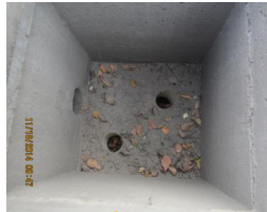
Sedimentation Manhole
