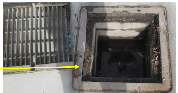
Sedimentation Manhole
