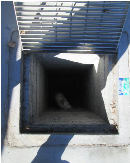
Sedimentation Manhole
